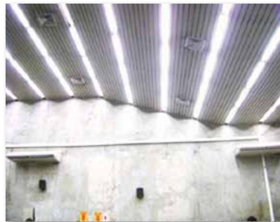
Figura 3: auditório após retrofit
