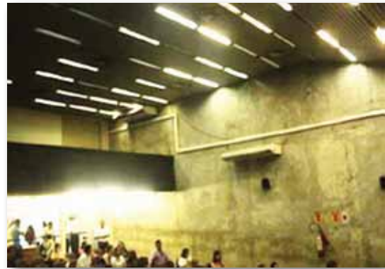
Figura 2: auditório antes do retrofit
