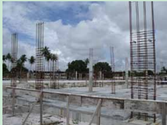
Obras do Novo Parque Tecnológico
